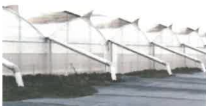
Sistema de recogida de agua de lluvias
