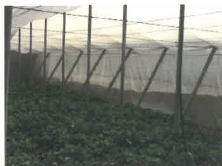
Mallas anti-trips en ventanas laterales de invernaderos
