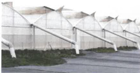
Sistema de recogida de agua de lluvias
